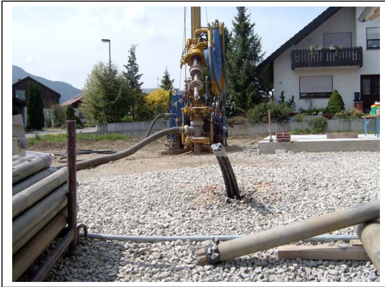
Abb. 3 Sondenbohrungen im Festgestein mit dem Imlochhammer
