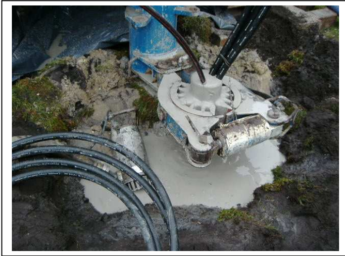
Abb. 5 Fachgerecht verpresste EWS nach Abschluss der Verpressarbeiten
